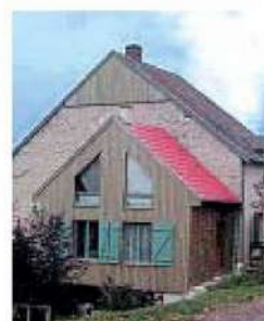
Percements en pignon
