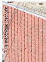
Tuile mécanique losangée
